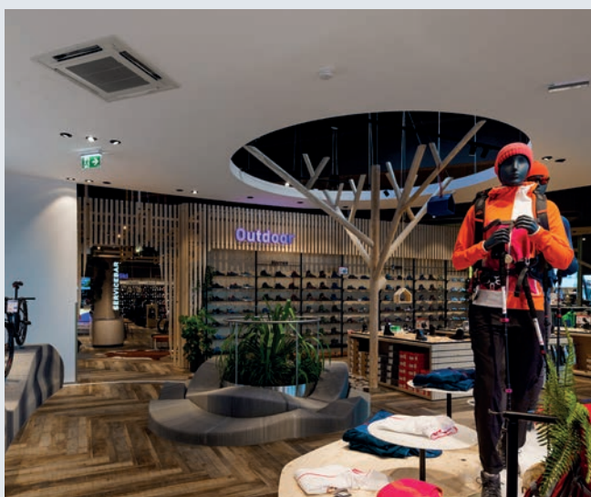
PADO Shopping Galerien Pamdorf, CAVERION Österreich GmbH Klimaanlage und Wärmepumpen
